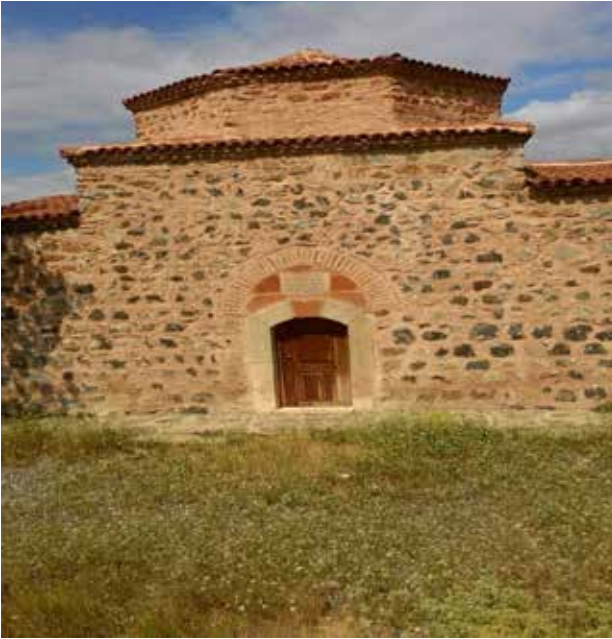
Fotoğraf 2. Çöreğibüyük Türbesi Doğu Cephesi
