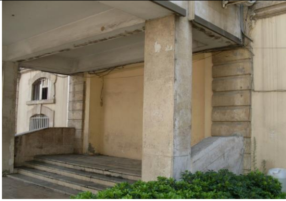
Resim 14. Eski Belediye Sarayı Binası Batı Cephe
