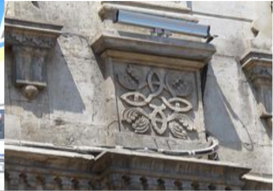
Resim 17. Eski Belediye Sarayı Kuzey Cephe Giriş Katı
