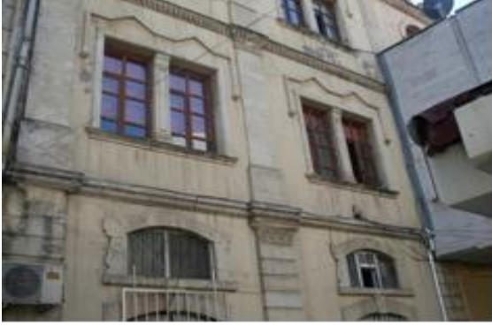
Resim 12. Eski Belediye Sarayı Binası Batı Cephe
