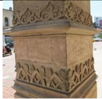
Resim 9. Giriş Cephesindeki Sütun Süslemelerinden Ayrıntı
