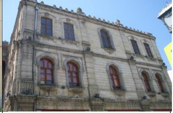
Resim 15. Eski Belediye Sarayı Binası Kuzey Cephe
