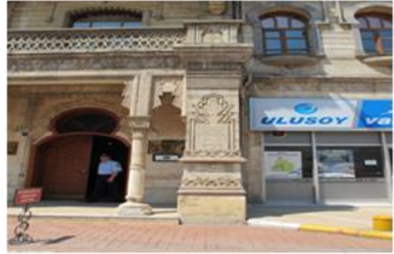
Resim 7. Eski Belediye Sarayı Binası Giriş Cephesi
