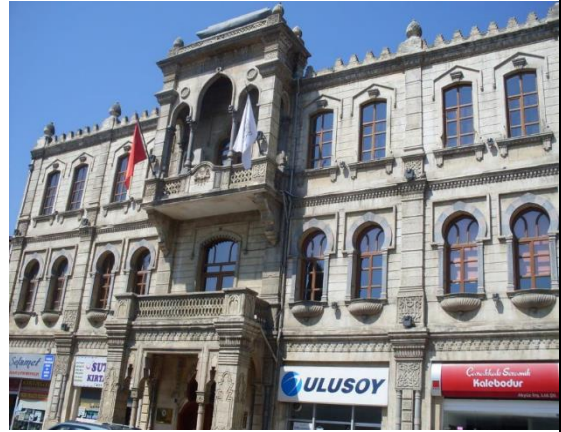
Resim 1. Eski Belediye Sarayı Binası Doğu Cepheden
