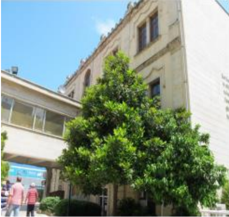
Resim 10. Eski Belediye Sarayı Binası Batı Cephe
