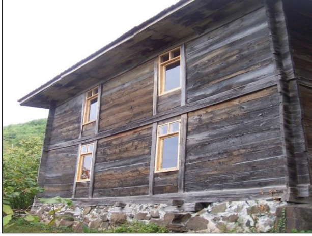
Foto 11: Çökek Köyü Merkez Camisi
