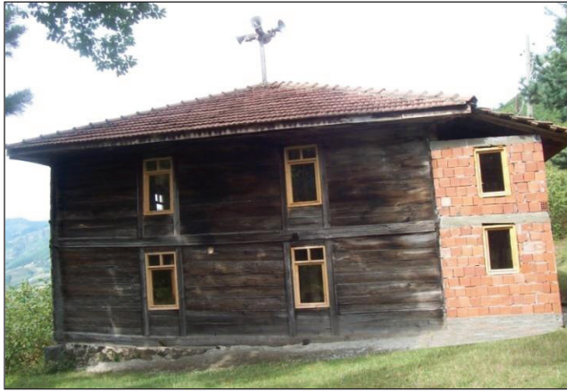
Foto 10: Çökek Köyü Merkez Camisi
