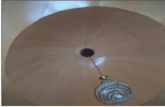
Foto 12: Çökek Köyü Merkez Camisi
