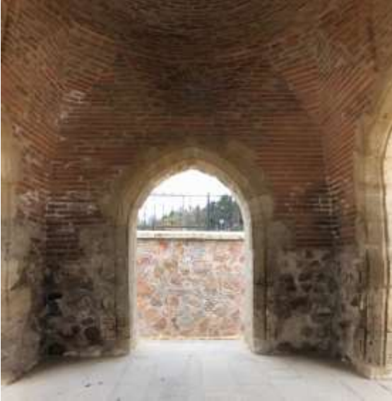
Görsel 17. Erenler Türbesi, türbe içinden görünüm. Moloz taş ve tuğla kullanımı
