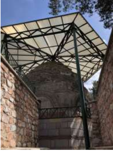
Görsel 2. Burgaç Hatun Türbesi, restorasyon sonrası durumu
