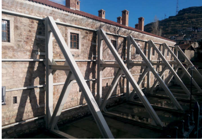
Resim 3. Yapıda uygulanan çelik payanda sistemi.
